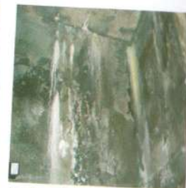
Karbonizacija betona (bije fleke)
