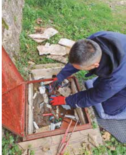
Slika 2. Zamjena vodomjera u vodomjernom šahtu
