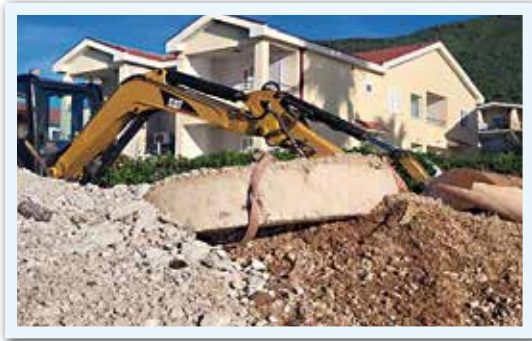
Slika 5. Izvađena zemlja sa šljunkom iz rova i betinski prsten šahta – uzročnik pucanja cijevi
