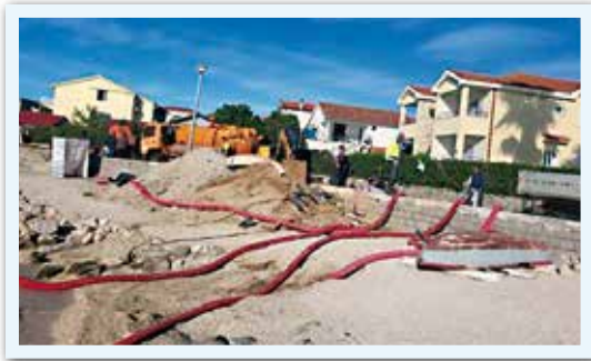
Slika 6. Iscrpljivanje vode iz rova
