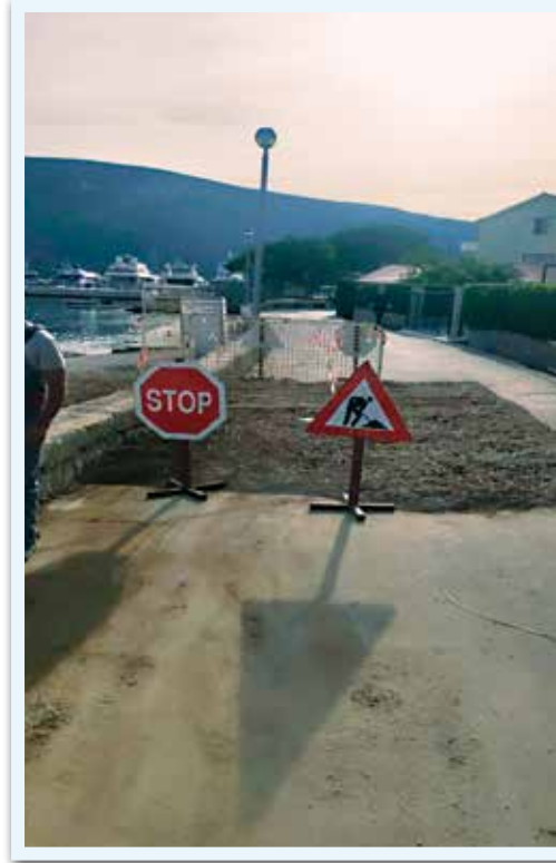
Slika br. 7. Lokacija nakon završene sanacije.
