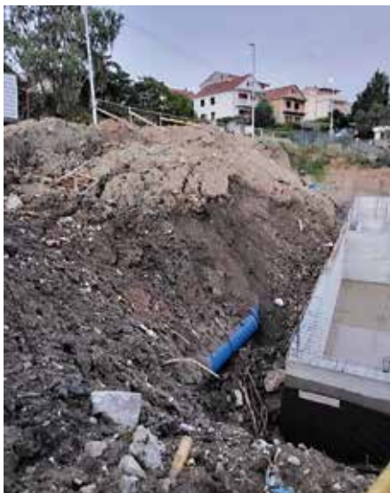
Изглед локације са зашрпаним цјевоводом од њокренуће земље и изглед цјевовода након уклањања наслоја земље са њоремећеном шрасом
