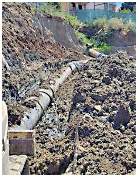
Радови на ископавању цјевовода и ојкопан цјевовод
