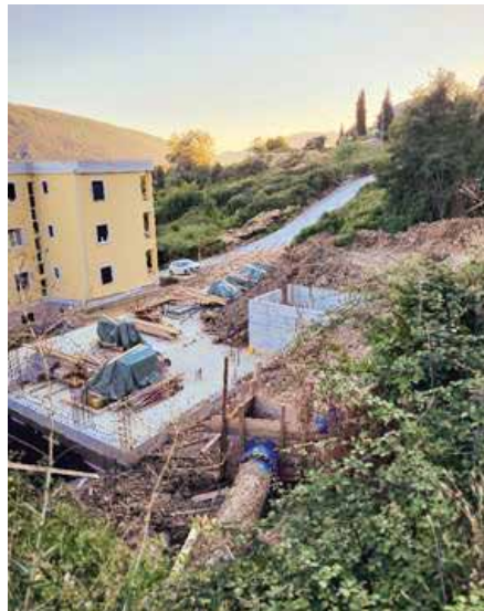
Изглед градилиштя са цјевоводом
