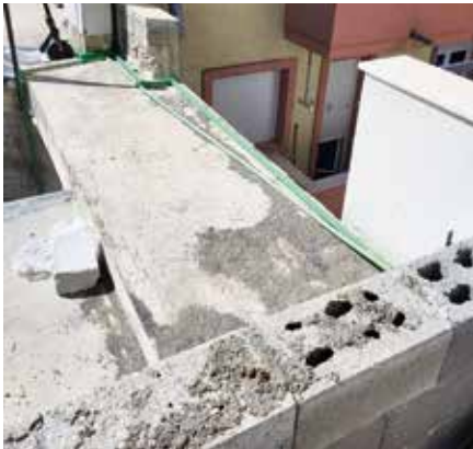
Na slici objekat i vodovodna cijev iz jedne do druge zgrade
