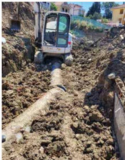
Изглед локације са зашрпаним цјевоводом од њокренуће земље и изглед цјевовода након уклањања наслоја земље са њоремећеном шрасом
